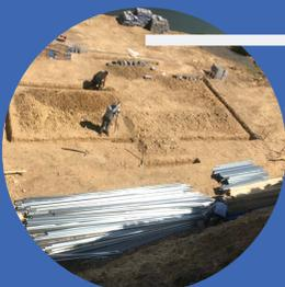
Trazado y excavaciones de la fundación de la construcción.
