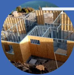
Inicio de estructura de la construcción en metalcon (acero galvanizado).
